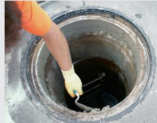
Mit hochwertigem Schachtvergussmörtel untergiessen wir den Schachtrahmen. Der laborgetestete Mörtel ist frost- und tausalzbeständig und widersteht höchsten Belastungen durch den Strassenverkehr. Die Arbeit mit diesem Produkt setzt grosse Erfahrung voraus, die sich auch in der Dauerhaftigkeit und Sauberkeit des Arbeitsergebnisses zeigt. Am Schluss entfernen wir die Mörtelreste und reinigen die Schachtsohle.
