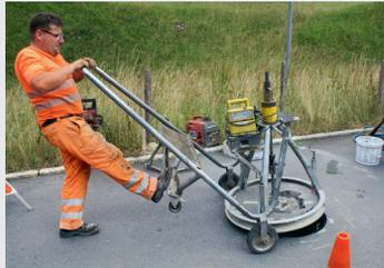
Nachdem das Pickelloch freigelegt und auf dem neuen Belag gekennzeichnet ist, ziehen wir den Schachtdeckel durch den Deckbelag auf die exakte Fertighöhe. Dank unseres elektrohydraulischen Hebegeräts sind wir dabei wesentlich schneller und präziser als mit herkömmlichen, manuellen Zugmethoden. Gerne überzeugen wir auch Sie mit unseren eingespielten Arbeitsabläufen, unserer Genauigkeit und einer speditiven Auftrags erledigung.
