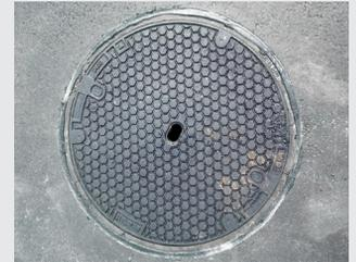
Durch das Nachschneiden der Abschärkanten entlang der Belagsränder wirken die Vergussfugen besonders sauber. Mit Heissvergussmasse versiegeln wir die Abdichtung von Belag und Gussdeckel und schützen sie dauerhaft gegen Nässeinbruch, damit kein Frostwasser eindringen und die Belagsränder zerstören kann. Der abschliessend mit Quarzsand bestreute Schachtdeckel ist sofort wieder befahr- und begehbar.
